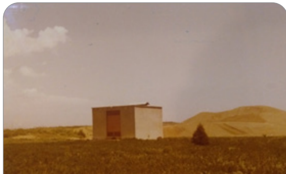
ج) پست برق باغ سیستماتیک.
